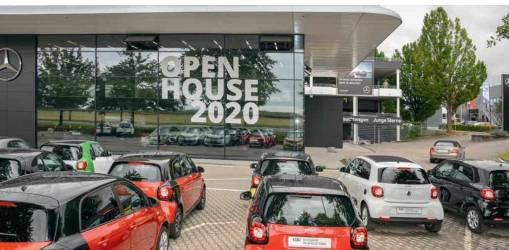
Von Kopf bis Fuß im MAR2020-Stil: Das Anfang des Jahres 2020 fertiggestellte 1.300 Quadratmeter große neue Verkaufs- und Ausstellungsgebäude des Autohauses Klotz am Standort Fellbach.
